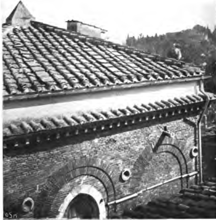
Bild 5. Teil der Südseite der Kapelle Sancta Sanctorum.
